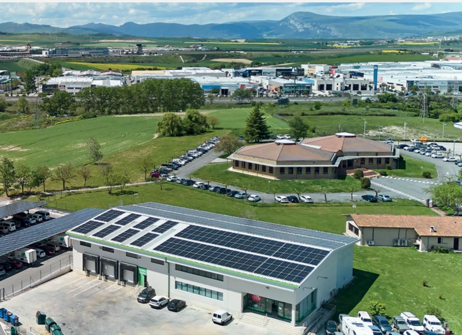
**D**urante los meses de abril y mayo se han estado realizando las pruebas de la nueva instalación fotovoltaica de Caceco, que a fecha de cierre de la revista ya funciona a pleno rendimiento. La fábrica de pienso del Grupo AN, situada en Tajonar, ha instalado algo más de 2.400 paneles solares, distribuidos entre los tejados de los almacenes de cereales, la tienda del Grupo AN en Tajonar, el almacén de Frutas Sheila y dos grandes marquesinas solares situadas en la zona de aparcamiento.
