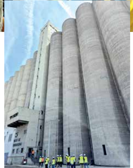
Silo cerealista dentro de las instalaciones del puerto de Tarragona
